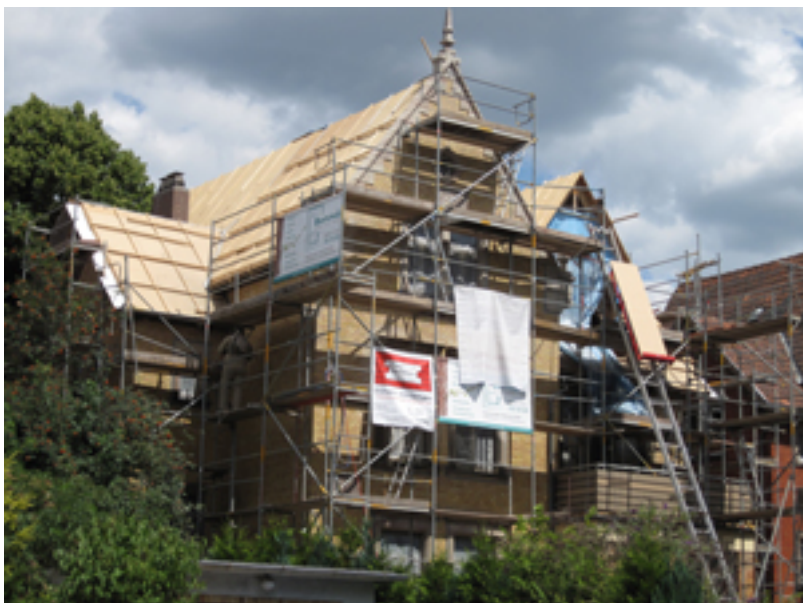
Ausbau und Sanierung des Daches
