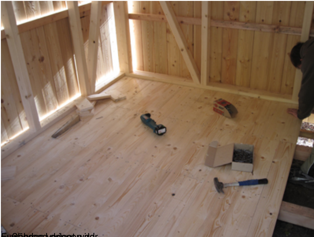
Fußbodenmontage im Innern
