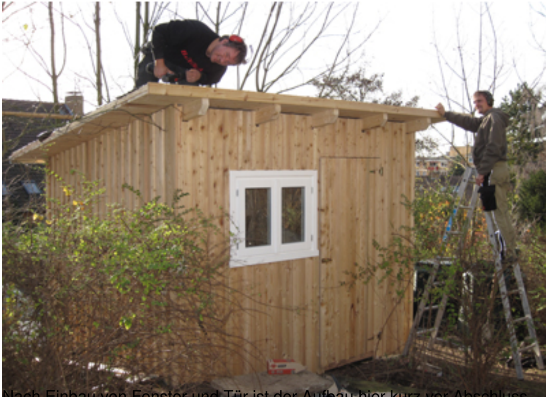
Nach Einbau von Fenster und Tür ist der Aufbau hier kurz vor Abschluss.
