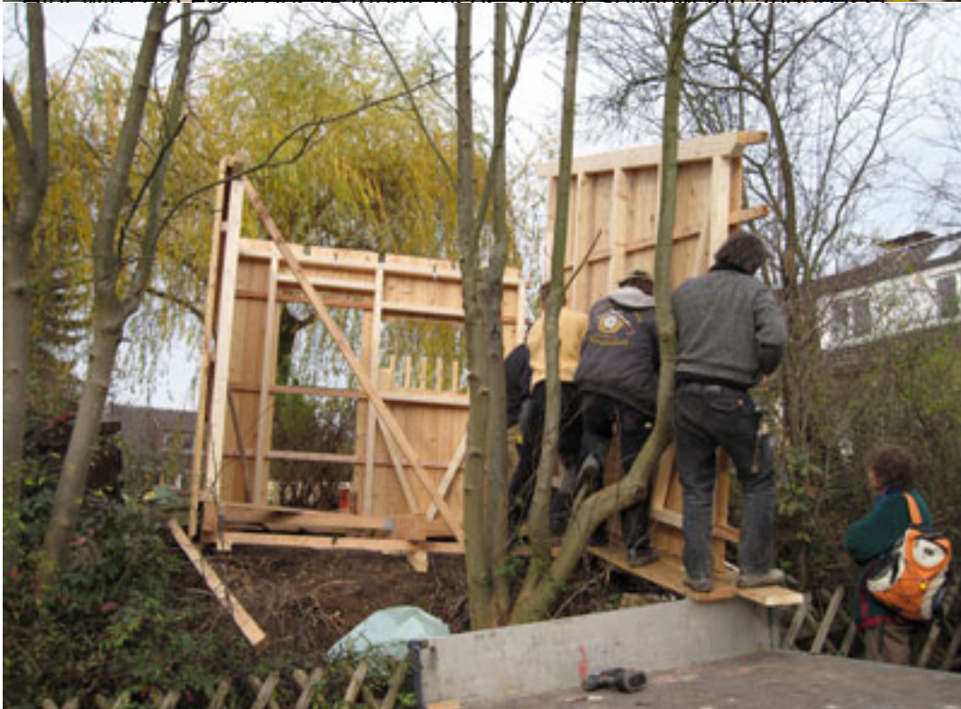
Grundmauerwerk ist notwendig, um die dritte Wand vom Hänger durch die Bäume auf das
