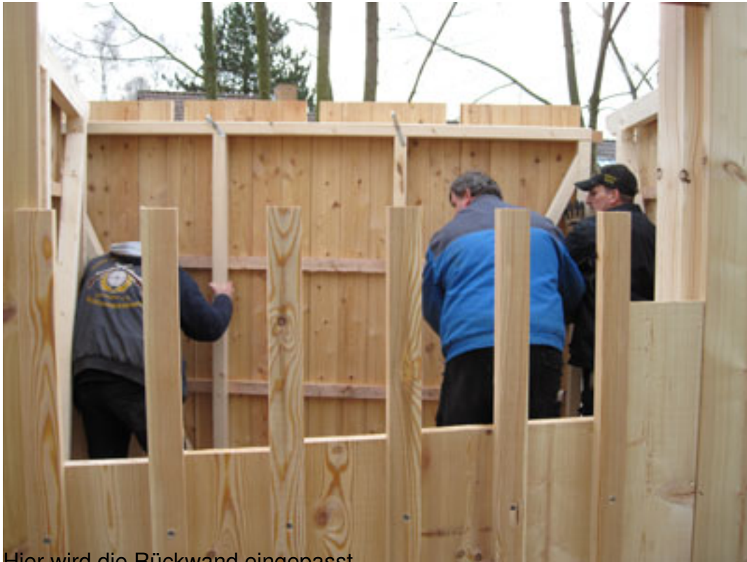
Hier wird die Rückwand eingepasst.
