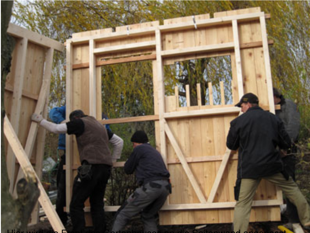
Hier wird die Fensterrahmenstruktur des Gartenhauses montiert.
