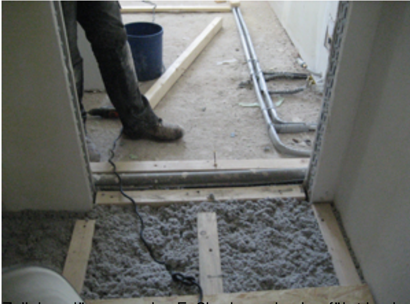
Zellulosedämmung des Fußbodens, durchgeführt in einem Privathaus in Göttingen
