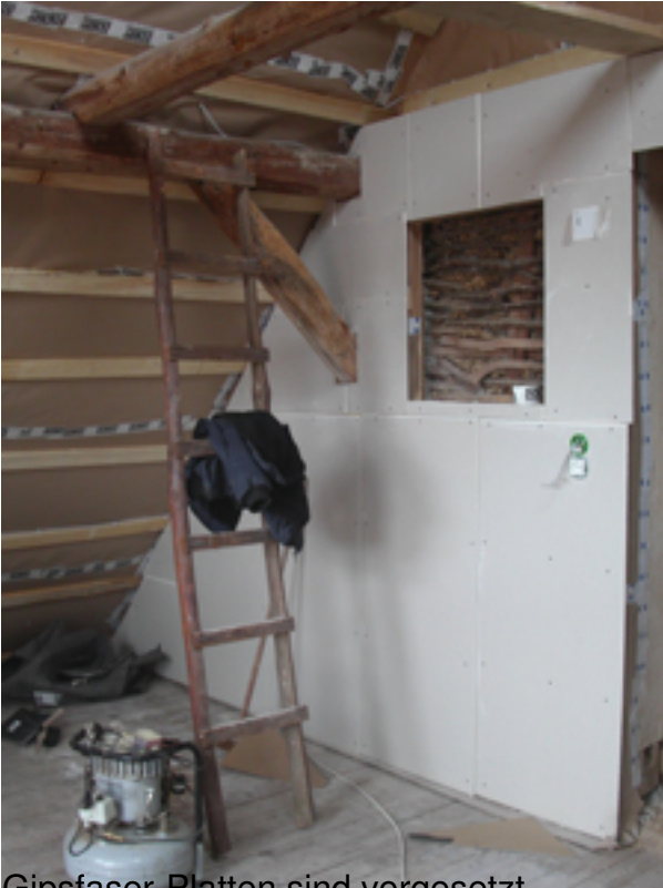
Gipsfaser-Platten sind vorgesetzt.
