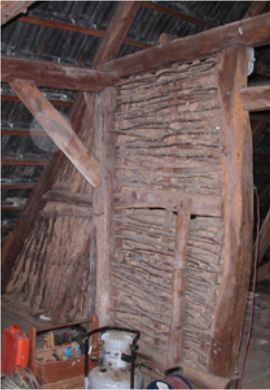
So sahen die Wände im Dachstuhl vor der Dämmung aus.
