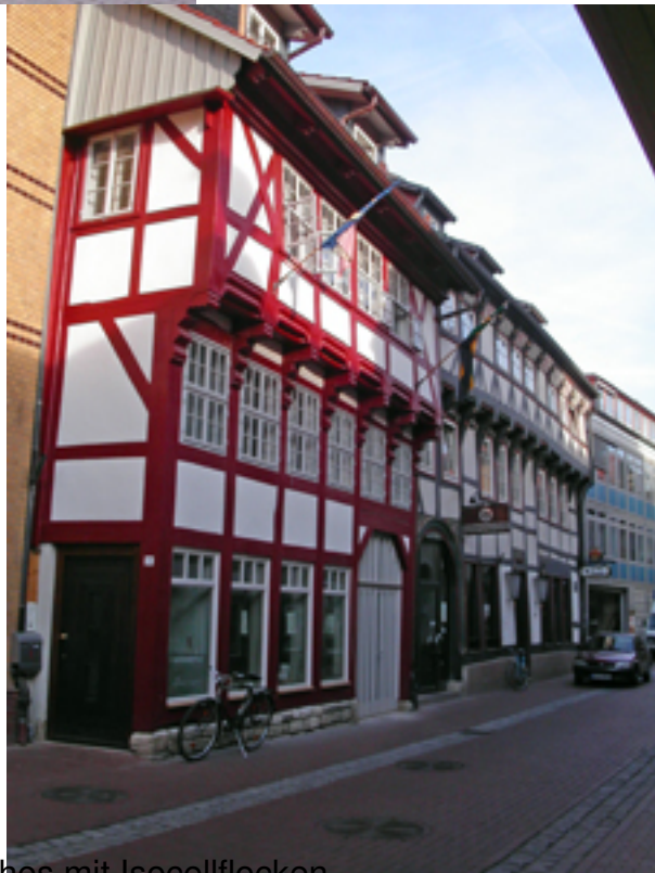
Wärmedämmung durch Einflochten des Daches mit Isocellflocken.
