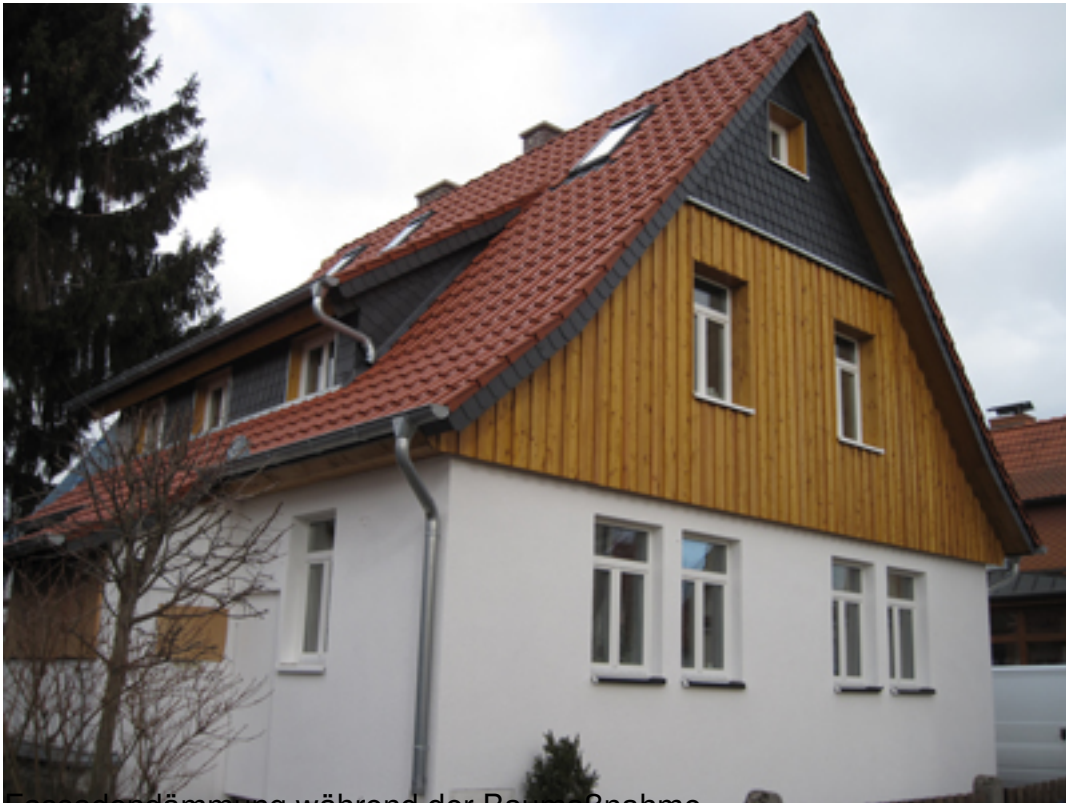
Fassadendämmung während der Baumaßnahme
