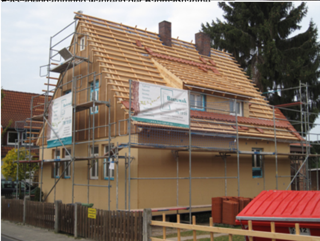
Vor der Dach- und Fassadendämmung:
