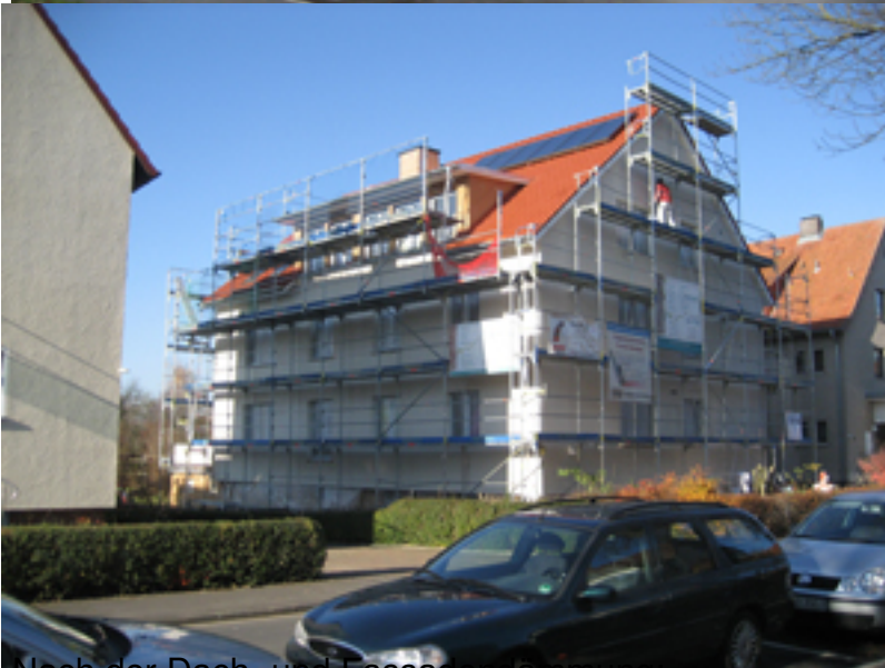
Nach der Dach- und Fassadendämmung.
