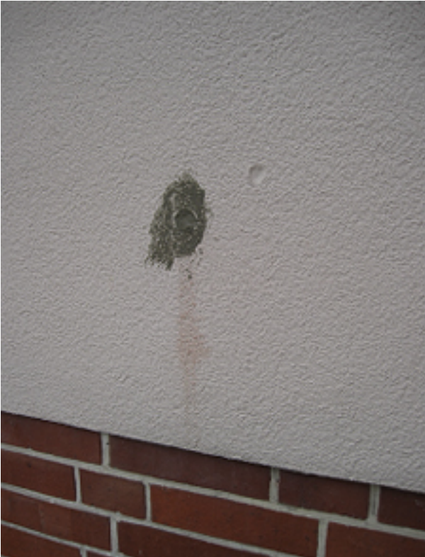
Die Fehlmontage zeigt sich durch die fehlende Abdichtung der Fenster 4 bis 5 Jahren
