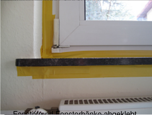
Fenster und Fensterbänke abgeklebt.
