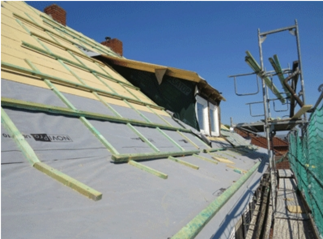
Dämmung mit Holzweichfaserplatten und einer Zelloosedämmung darunter
