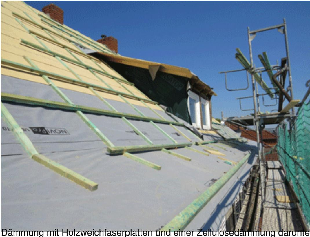
Dämmung mit Holzweichfaserplatten und einer Zelloosedämmung darunter
